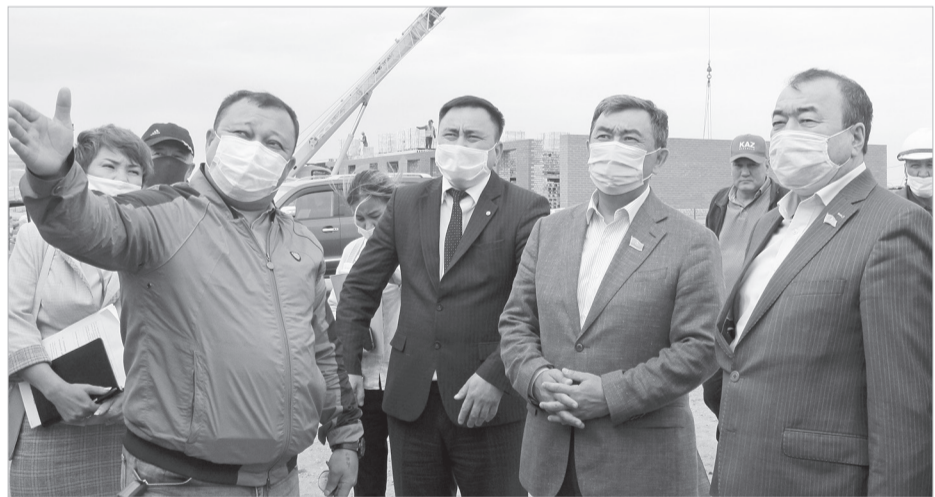
ҚР Парламент Мәжілісінің депутаты Арман Қожахметов Жезқазған қаласында жаңадан салынып жатқан 3 көпқабатты тұрғын үйдің және 200 орындық инфекциялық аурухананың құрылысымен танысты.
